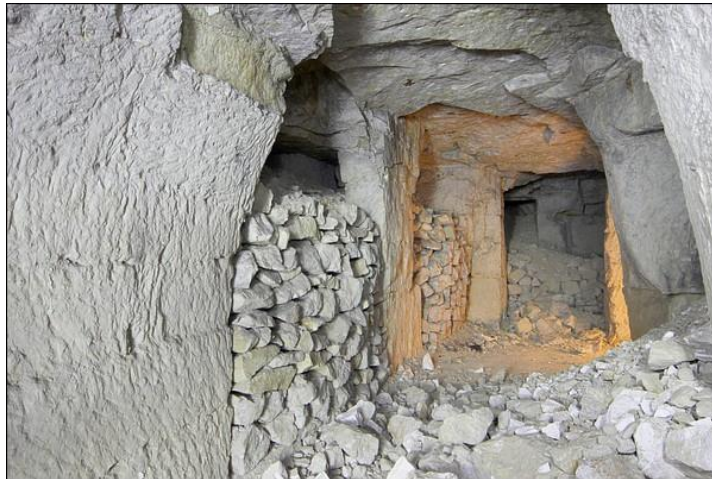
Photographie d'une galerie à Lieu-Saint-Amand (village voisin) (uopcku – patrimoine industriel, civil et souterrain)
